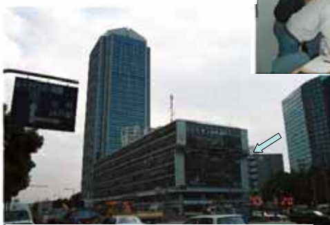
市庁舎の倒壊でコンピュータ室が被災
