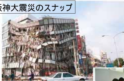
壊れないと思っていたビルが倒壊
