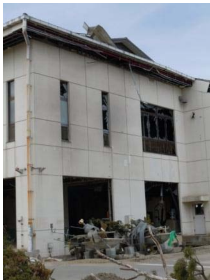
被災した屎尿処理場
