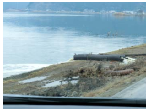
浸水地域でのポンプ車による新北 上川への排出（石巻）
