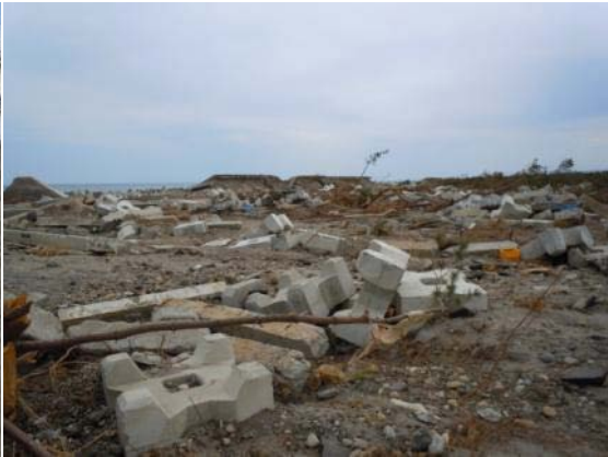
堤防決壊によりコンクリート散乱
