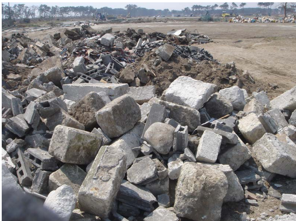
C：ガレキ（コンクリ、ブロック、瓦など）の仮置き場
