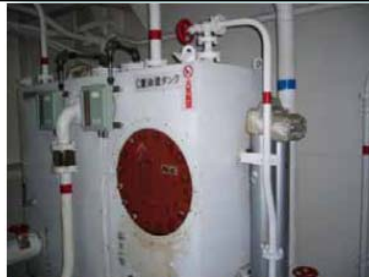
(タンクの保温。保温板の上に表面にアスベストクロスを貼り付けて、金網で補強、右はブリキ板で補強してあります。)
