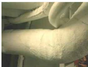
(アスベストクロスを蒸気配管に巻いている)
