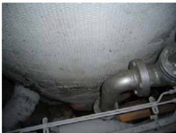
(タンクの保温。保温板の上に表面にアスベストクロスを貼り付けて、金網で補強、右はブリキ板で補強してあります。)
