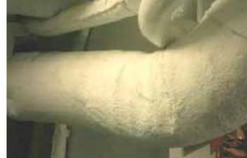
(アスベストクロスを蒸気配管に巻いている)
