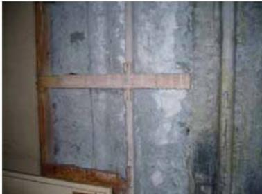
(居住区壁裏の吹き付けアスベスト材)
