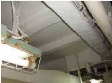
(天井に吹き付けられた結露防止アスベスト材)
