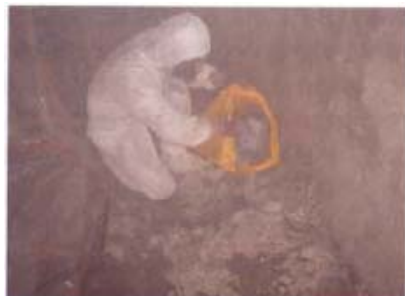
除去した吹付けアスベスト（レベル1）の袋詰め
