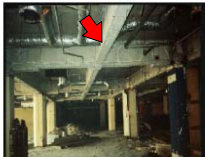
アスベスト含有ケイ酸カルシウム板 (鉄骨耐火被覆材)
