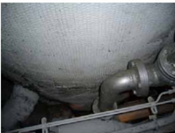
(タンクの保温。保温板の上に表面にアスベストクロスを貼り付けて、金網で補強、右はブリキ板で補強してあります。)
