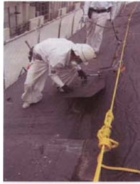
手ばらしによる成形板の取り外し
