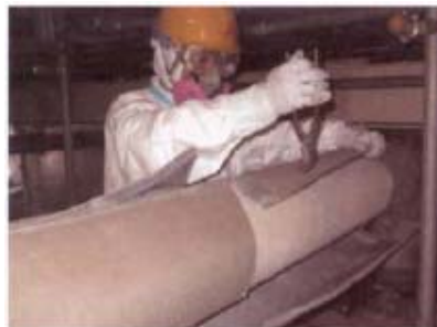
保温材（レベル2）の被覆の除去
