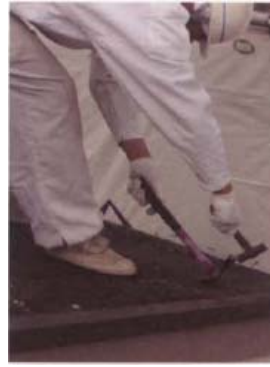
複合固定部分の取り外し
